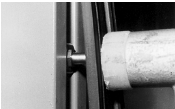
Abb. 3 Perforieren der Innendichtung Ill. 3 Perforation du joint intérieur
