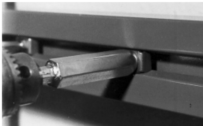
Abb. 2 Anziehen des Ankers Ill.2 Serrer le boulon d'ancrage anti-incendie
