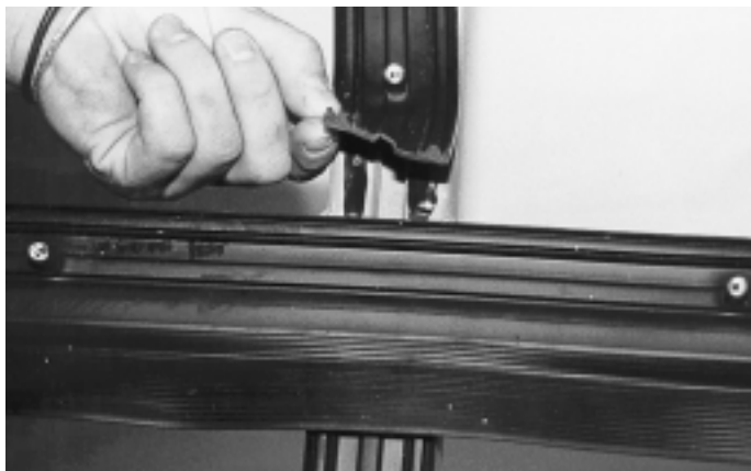
Abb. 6 Kreuzpunkt mit Kleber-Raupen Ill. 6 Point de croisée avec traînées de mastic à coller
