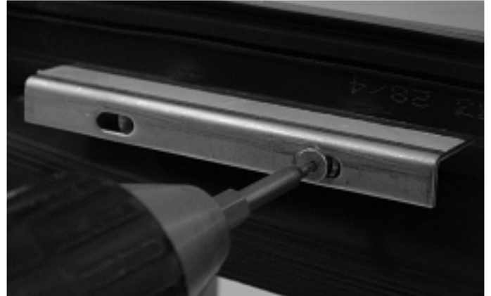
Abb. 5 Anschrauben des Glasauflagers III. 5 Visser le support de verre
